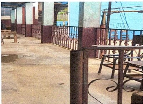
Foto 7. Mantenimiento a barandas metálicos , icluye lijado y pintura.
