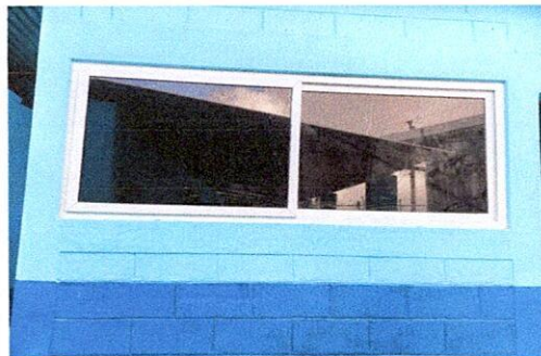
Foto 2: Sustitución de ventanas; sistema de apertura: corredizas, perfiles color blanco estandar, material del marco: PVC material de la ventana: Vidrio, sellado perimétral.
