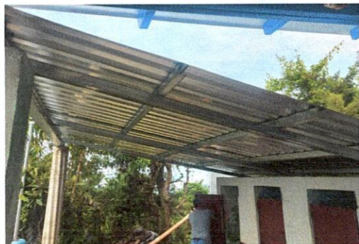
Foto 1: Sustitución de cubierta de techo con lámina galvanizada, Tipo de mina: troquelada calibre : 26, incluye fijaciones y sellado en traslapes.
