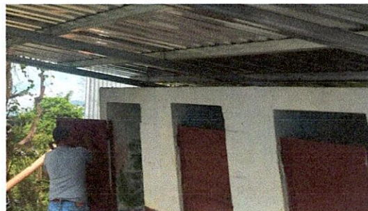
Foto 6: Mantenimiento a puertas metálicas existente retiro de óxido, suciedad y pintura deteriorada; incluye cepillado, lijado y aplicación de pintura.
